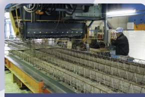
コンクリート打設
