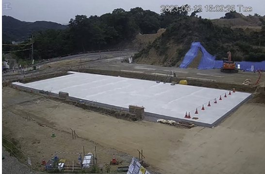
1 基礎コンクリート敷設
