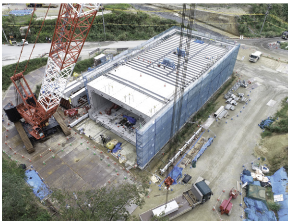
8分割ボックスカルバート:内空幅14.6m×内空高6.5m
