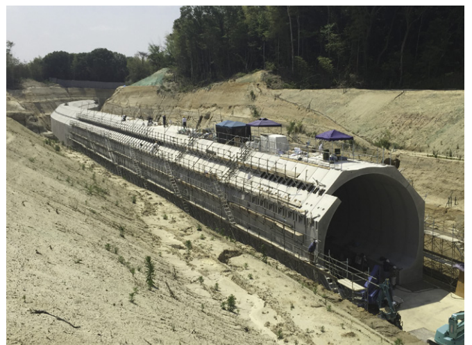
奈良県内 3分割タイプ (内空幅9m、内空高7.3m、内空半径4.5m)
