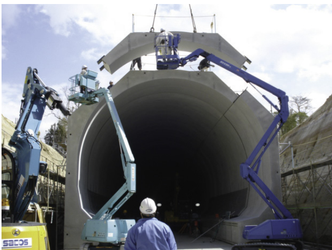
奈良県内 3分割タイプ (内空幅9m、内空高7.3m、内空半径4.5m)
