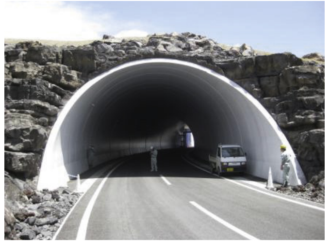
群馬県内 3分割タイプ (内空幅10m、内空高7.34m、内空半径5m)
