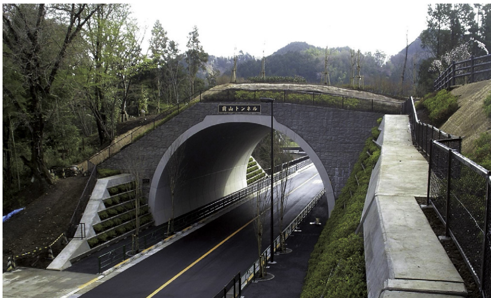
西多摩 平成19年度施工 幅員12.5m 内空高7.8m 内径6.0m
