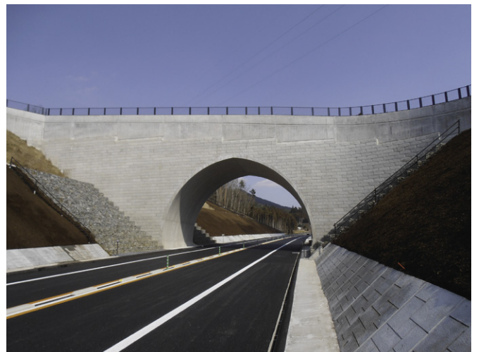
岩手県内 4分割タイプ (内空幅14.4m、内空高9.66m、内空半径8m、盛土FCB)
