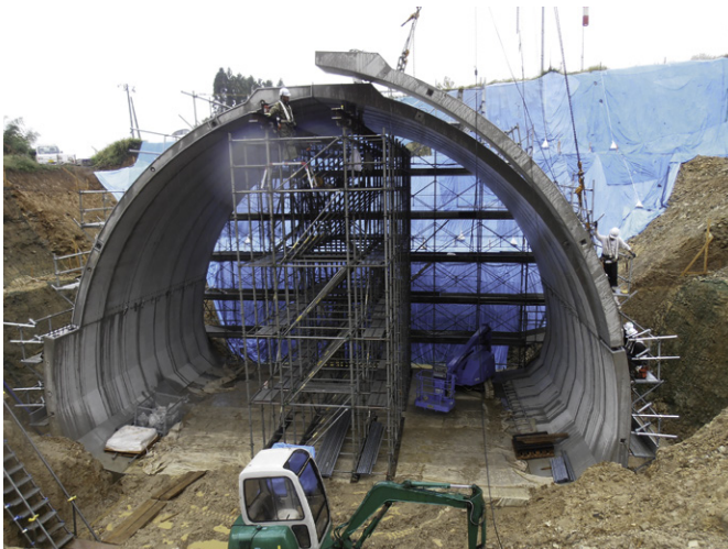
岩手県内 4分割タイプ (内空幅14.4m、内空高9.66m、内空半径8m、盛土FCB)
