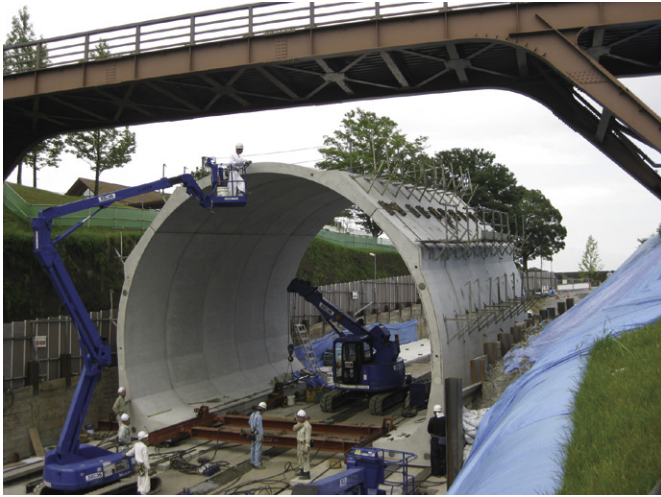
群馬県内 3分割タイプ (内空幅10m、内空高7.34m、内空半径5m)
