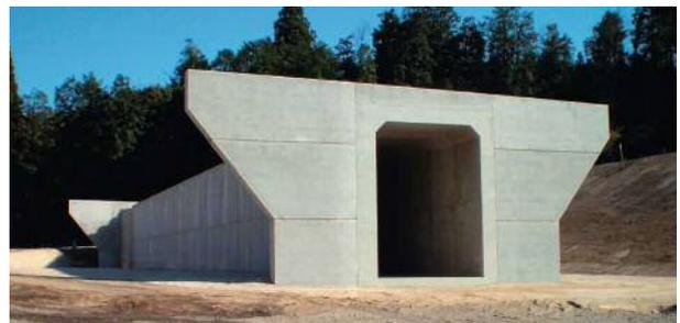
プレキャストボックスカルバートとの併用により、大幅な工期短縮と高品質な施工が可能となり、トータルコストの縮減が図れます。
