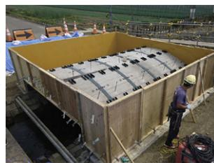
バックフィル用型枠組立完了
