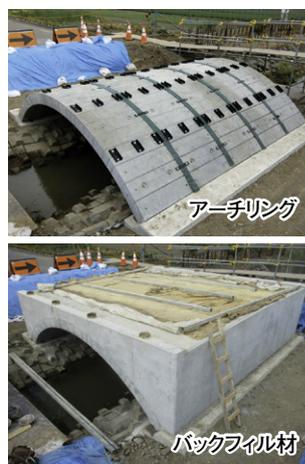
アーチリングは支保工とバックフィルコンクリートの底面型枠両方の役割を受け持ちます
