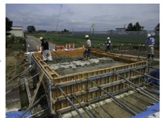
バックフィルコンクリート打込み
