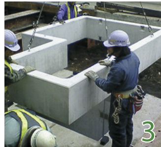
土留めブロック裾付け
