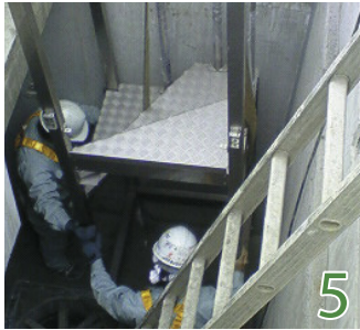
階段搬入及び設置
