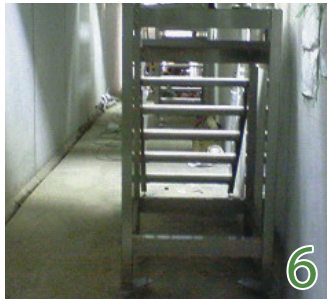
階段設置完了
