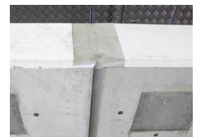
目地部シーリング
