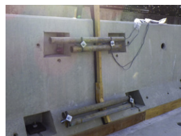
断面モルタル型枠
