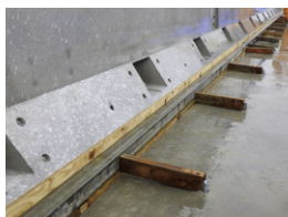
底面モルタル型枠
