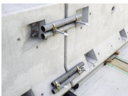
単管パイプによる位置調整
