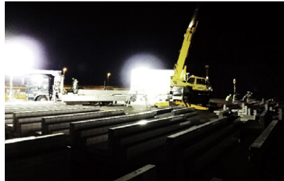
施工時積み込みは15t吊ラフターを使用
