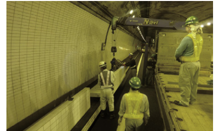
夜間通行止 据付状況(搬入トラックのユニックを使用)
