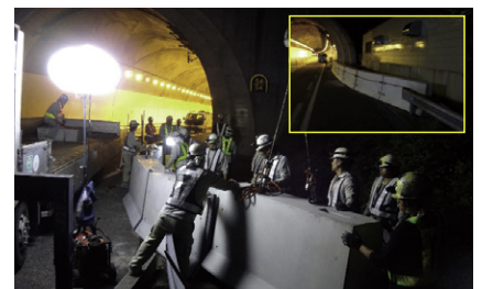
坑口防護(コンクリート防護柵)
