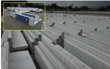
仮置き状況(近隣チェーンベース)
