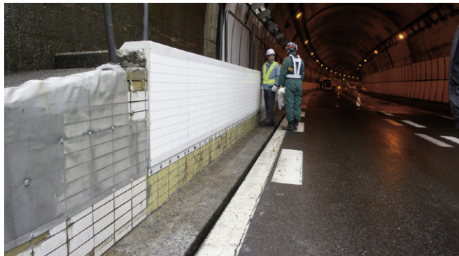
柳ヶ瀬TN上り坑口
