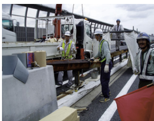
既設BOXビーム撤去
