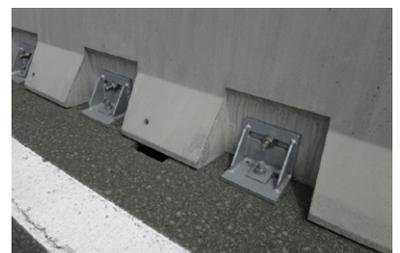
本設固定金具 床板鉄筋に当たらない自在構造
