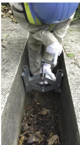
E・S・ジャッキは縦排水溝や小段排水溝などにイージーセーフシステムを取り付ける固定金具です。E・S・ジャッキの支圧板と本体の取り付け穴は45度の傾斜をもつ長穴となっており、軽い力で排水溝に取り付けたE・S・ジャッキにかかる上向きに引き上げる力は排水溝を押し上げる力に変換され、更に支圧板が排水溝に喰い込み、E・S・ジャッキが外れることはありません。
