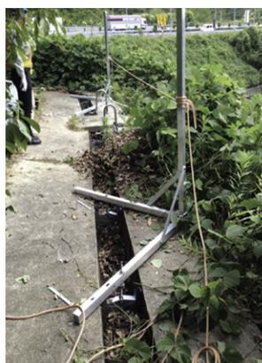
LサポFは折り畳み式の2本の脚をもつ転落防止綱固定支柱で、2台のE・S・ジャッキで小段排水溝に固定します。2台のLサポFを10m以内の間隔で設置し、転落防止綱を張って小段からの転落を防止します。転落防止綱にかかる法面下方向への荷重は
