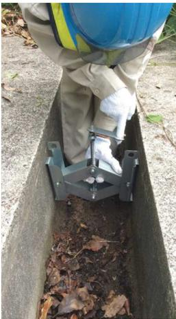
E・S・ジャッキは縦排水溝や小段排水溝などにイージーセーフシステムを取り付ける固定金具です。E・S・ジャッキの支柱板と本体の取り付け穴は45度の傾斜をもつ長穴となっており、軽い力で排水溝に取り付けたE・S・ジャッキにかかる上向きに引き上げる力は排水溝を押し上げる力に変換され、更に支柱板が排水溝に喰い込み、E・S・ジャッキが外れることはありません。
