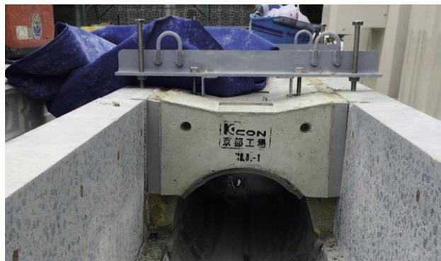
NER工法は、円型水路の老朽化して破損した部分を切断・除去し、水路部分をチューブ型枠で確保したのち、切除部分にプレキャストブロックを据えて隙間にジェットモルタルを充填し、新しい水路を完成させる工法です。
