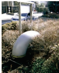
●地上部 換気孔
