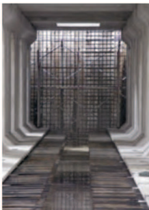
●現場打ち端壁
