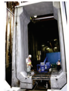
●ローラースライド工法 による据付施工
