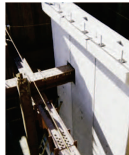
●切梁のある施工
