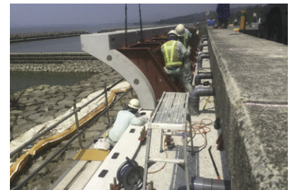
⑥ ブロック据付
