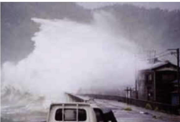
従来の護岸形式での被害状況
