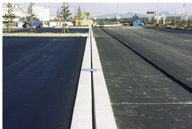
(施工後)名神高速道路 一宮P.A.
