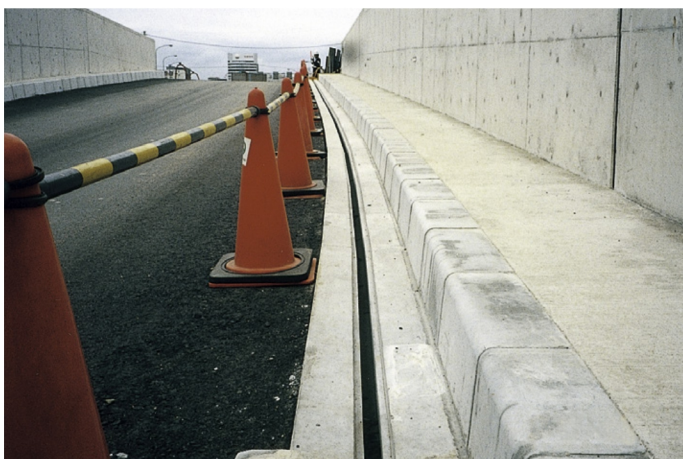
神戸市 港島トンネル道路
