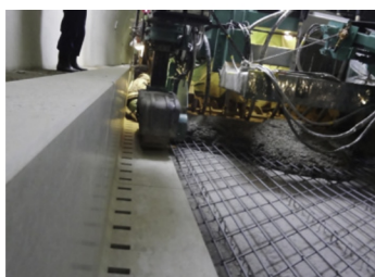
スリップフォーム工法によるコンクリート舗装例
