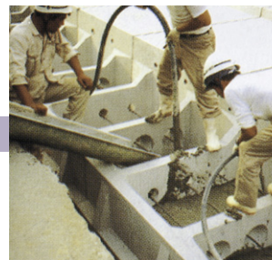
6 間詰コンクリート打設(鉄筋挿入)
