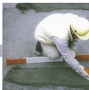
3 モルタル敷設
