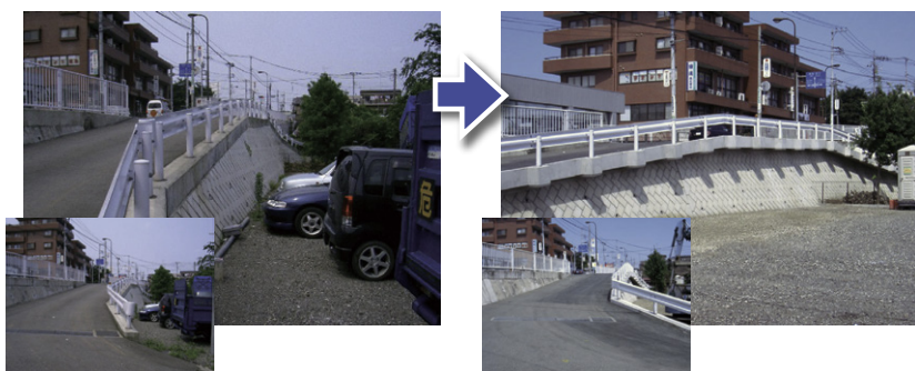
施主：東京都南多摩西部建設事務所 工事名：交差点改良工事
