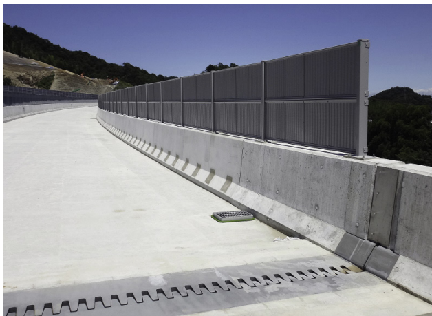
徳島県内(壁高欄)
