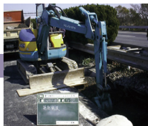
2. 既設撤去・掘削
