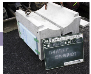
4. 凹部にEPS取付け(中央分離帯側のみ)
