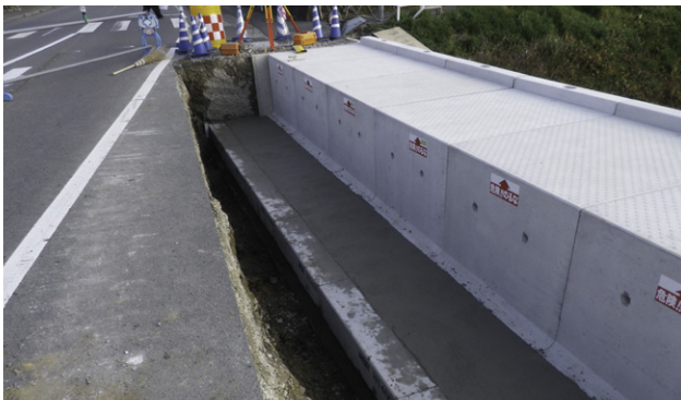
5 間詰コンクリート工
