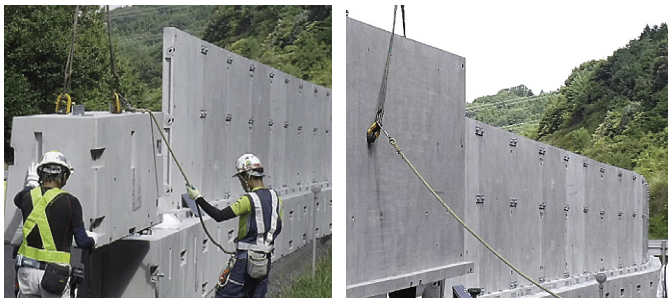
クレーンでの据付け状況
