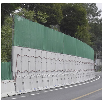
飛石防護ネットの取付け
