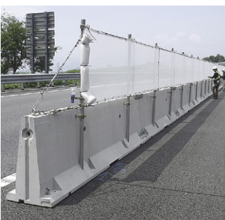
目隠しネットの取付け
