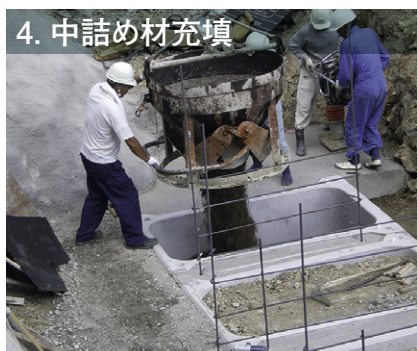
5. 胴込コンクリート打設
