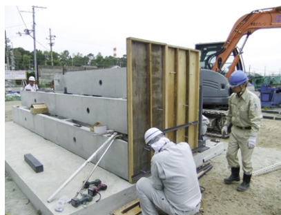
施工性確認・端部型枠設置
