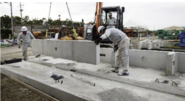
3 背面ブロック据付
