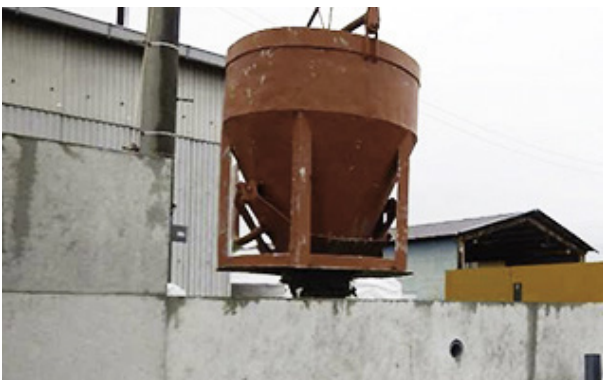
11 コンクリート打設
