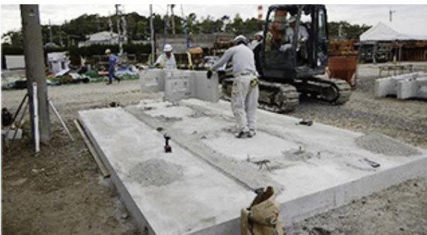
1 基礎工・レベル出し
