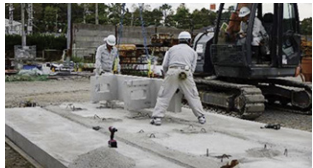
2 前面ブロック据付
