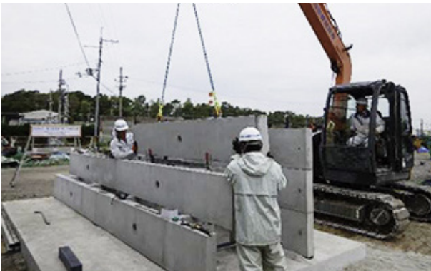
7 3段目据付 手順4~6と同様
