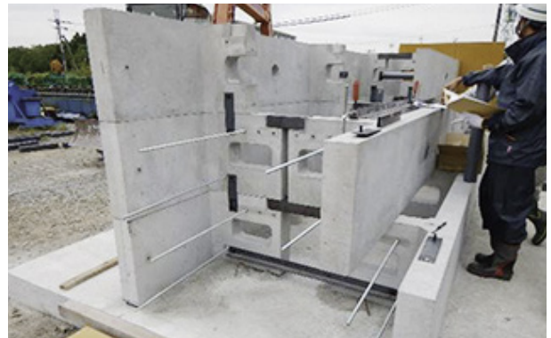
8 端部型枠固定用セパ設置(ブロックインサートを利用)
