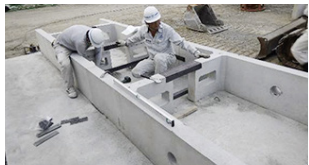
4 固定金物設置
