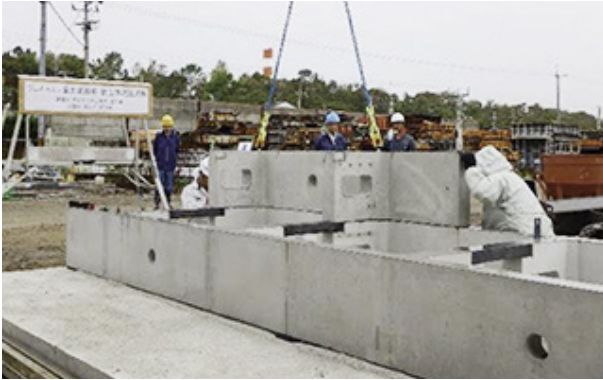
5 2段目前面ブロック据付
