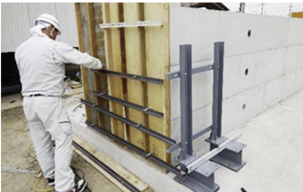
9 端部型枠設置
