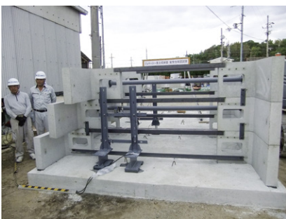
控え3.4m鋼材たわみ計測
