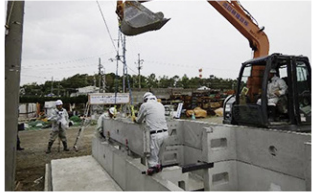
6 2段目背面ブロック据付
