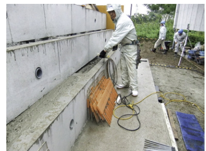
施工性確認・コンクリート打設
