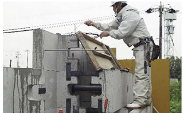
10 天端背面型枠設置
