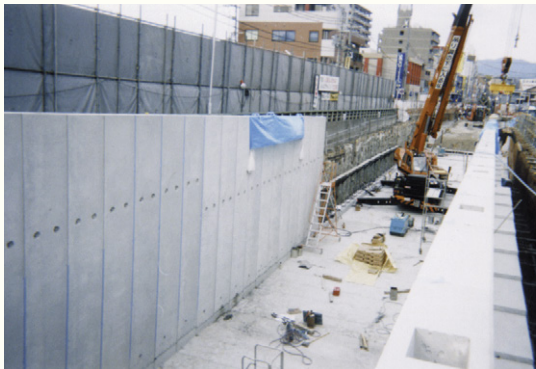
製品寸法：(U型)B×H×L=7.00×4.00~7.00×1.00m 施工時期：平成14年度 施工場所：大阪府高槻市
