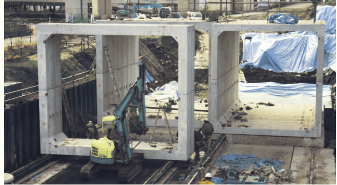
製品寸法：B×H×L=5.00 & 6.00×5.00×1.00m 施工時期：平成14年度 施工場所：京都府久世郡久御山町
