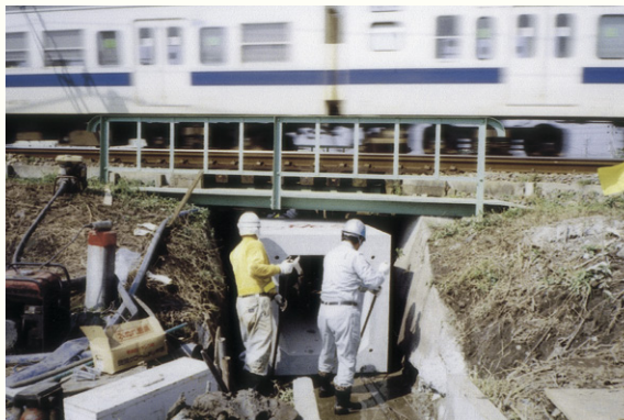
製品寸法：B×H×L=1.00×1.00×2.00m 施工時期：平成11年度 施工場所：茨城県藤代町
