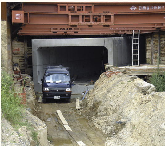
製品寸法：B×H×L=5.90×3.00×1.00m 施工時期：平成14年度 施工場所：和歌山県橋本市
