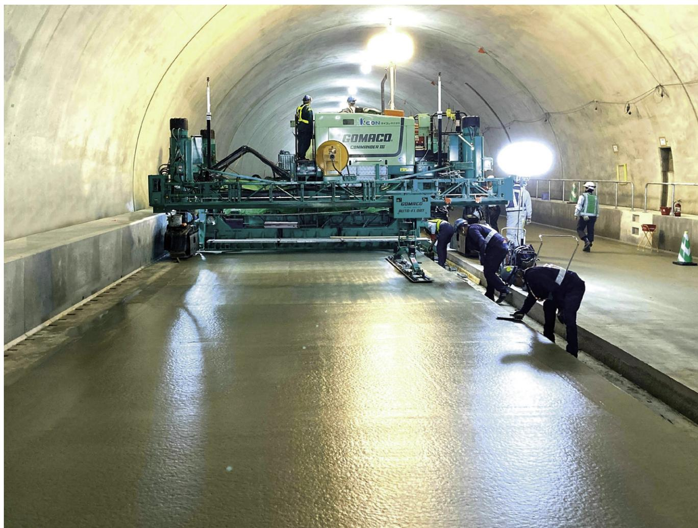
スリップフォーム工法とは成型機に鋼製の型枠(モールド)を取り付け、モールド内にコンクリートを供給し締め固めると同時に成型機を前進させることで、同一断面の構造物を連続的に打設していく工法です。
