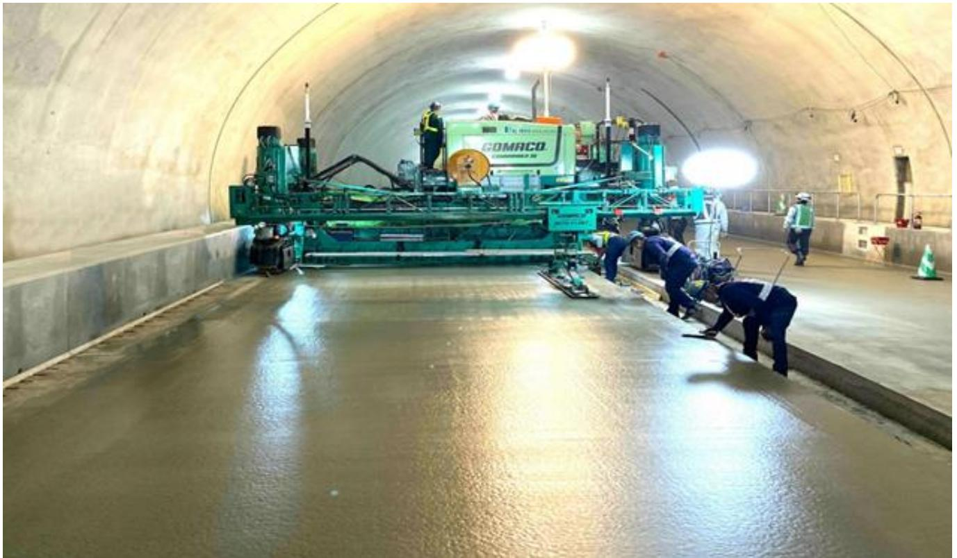
スリップフォーム工法とは成型機に鋼製の型枠（モールド）を取り付け、モールド内にコンクリートを供給し締め固めると同時に成型機を前進させることで、同一断面の構造物を連続的に打設していく工法です
