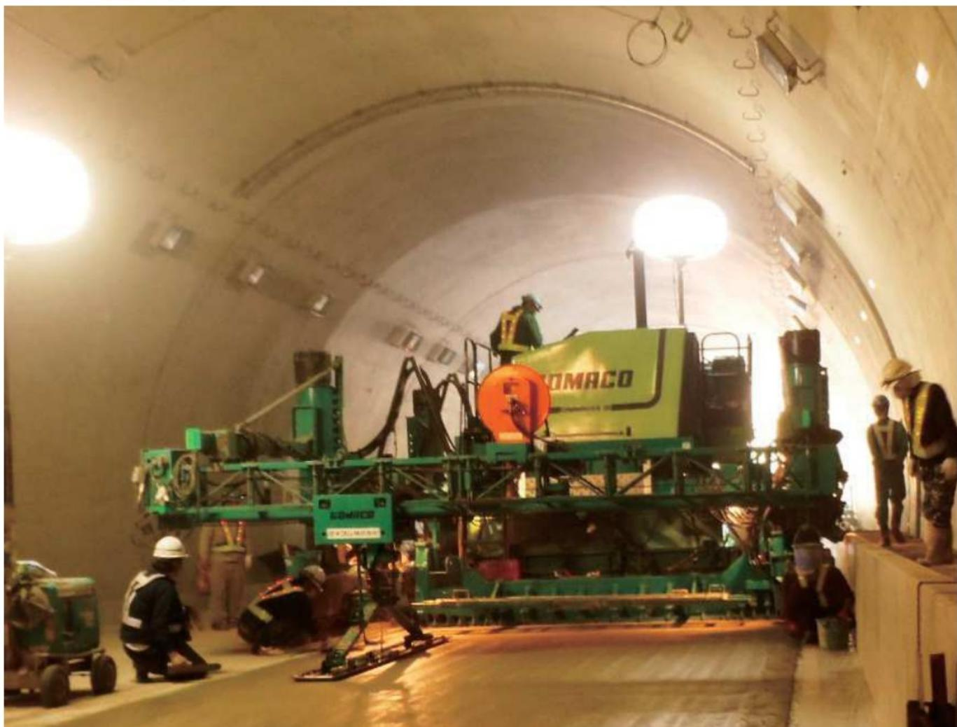
スリップフォーム工法とは成型機に鋼製の型枠(モールド)を取り付け、モールド内にコンクリートを投入し締め固めると同時に成型機を前進させることで、同一断面の構造物を連続的に打設していく工法です。
