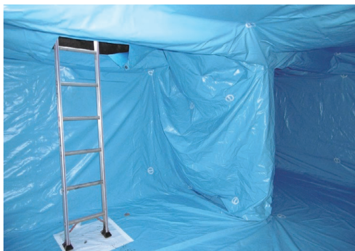
梁、柱を覆う形でKCガードを製作し設置
