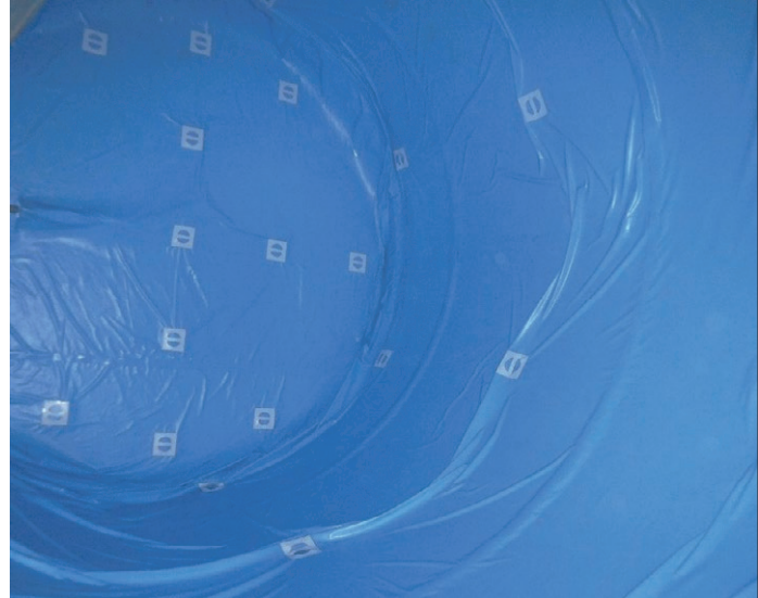
完成 下から見た状況
