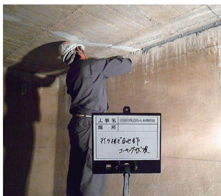
内部補修 打ち継ぎ目コーキング
