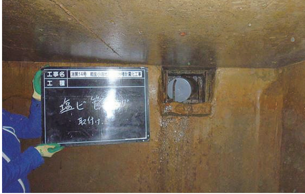
施工前 流入口有り
