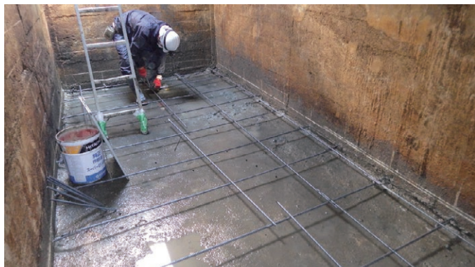
底面をコンクリートで補強
