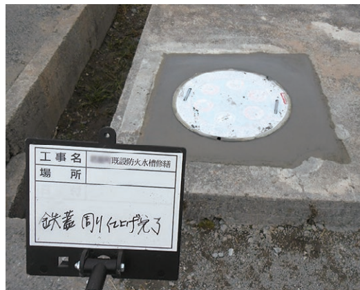
鉄蓋設置完了
