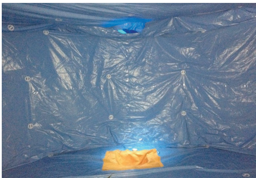
KCガード施工完了
