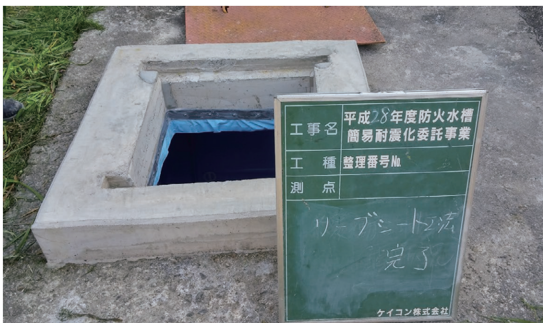
シート設置完成
