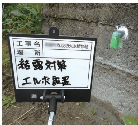
結露対策でエルボ設置
